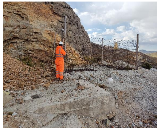
Geo-Logic elaboró la ingeniería de detalle para el cierre de chimeneas
