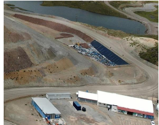
Geo-Logic desarrolló la ingeniería de detalle del relleno sanitario
